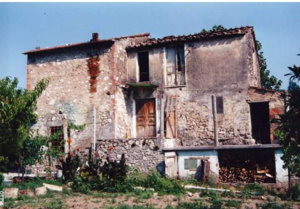
CONDIZIONI DEL CASALE NEL 1995 PRIMA DEL RESTAURO
